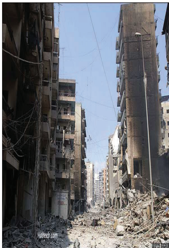
شکل ۲۶: تصویری از انسداد معابر با فروریزش ساختمان
